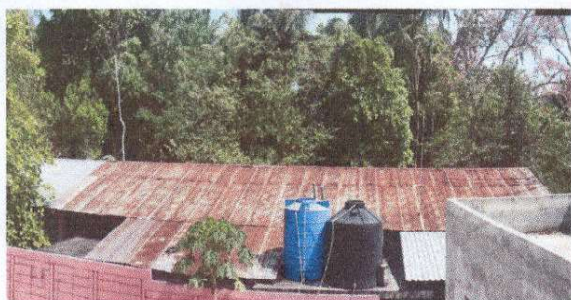
SUSTITUCION DE LAMINA POR LAMINA GALVANIZADA ALUZINC CL.26
