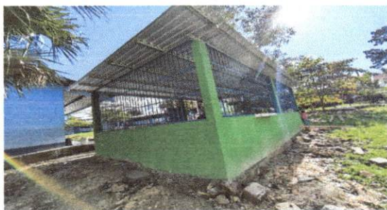
Foto 11: Reparación de muro de contención
