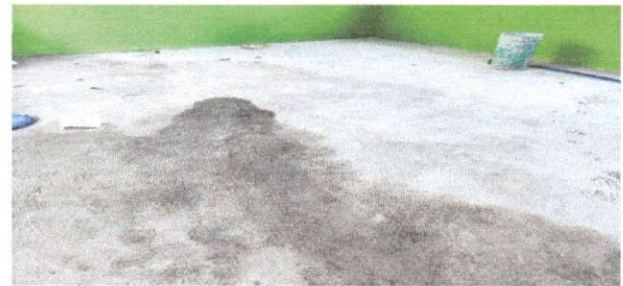
Foto 8: Sustitución de piso de torta de concreto
