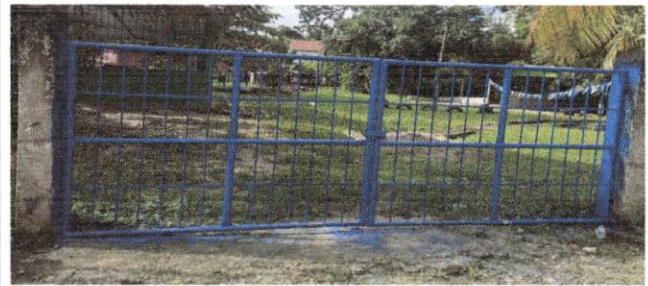
Foto 10: Mantenimiento a portones de metal
