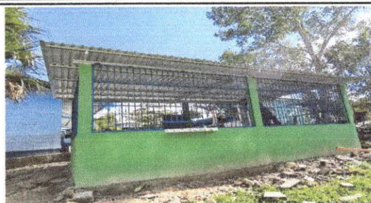
Foto1: Sustrucción de lámina, por lámina troquelada aluzinc calibre 26 modulos de aulas y cocina
