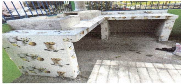
Foto 6: Instalación de azulejo en estufa rural
