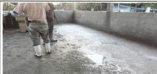
Foto 8: Sustitución de piso de torta de concreto
