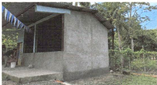
Foto 7: Repello en muro
