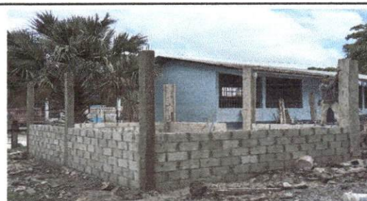
Foto 11: Reparación de muro de contención
