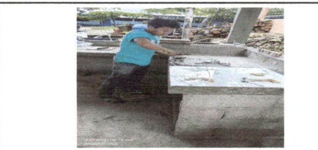
Foto 6: Instalación de azulejo en estufa rural
