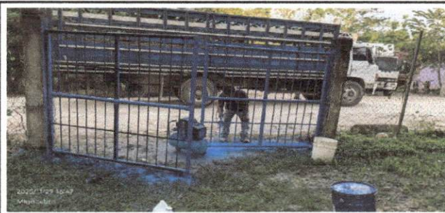
Foto 10: Mantenimiento a portones de metal
