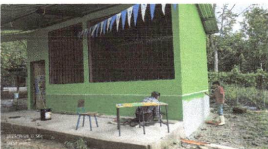
Foto 9: Pintura en muros exteriores e interiores
