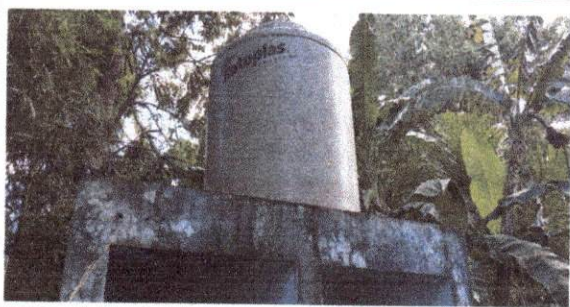
Foto 11: Sustrucción de deposito de agua 1700 lt
