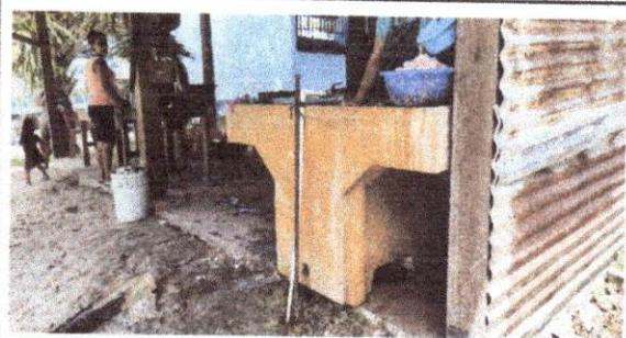
Foto 7: Sustrucción de pila de cemento de un lavadero
