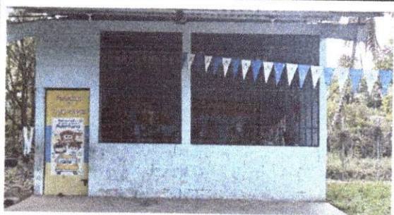
Foto 9: Pintura en muros exteriores e interiores
