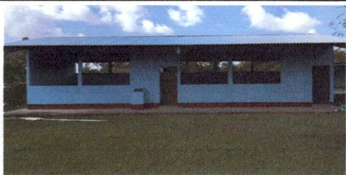
Foto 1: Sustitución de lámina, por lámina troquedala alizinc calibre 26
