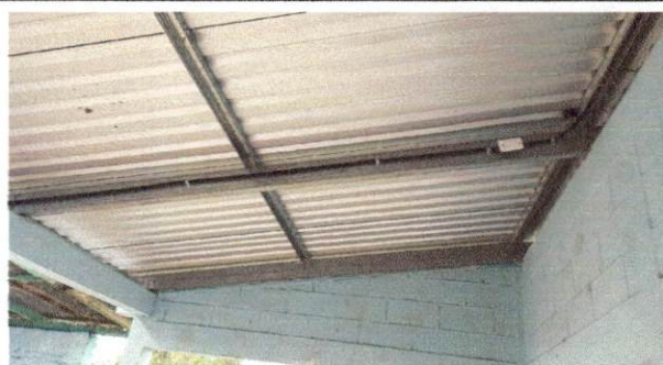
Foto12: Reparación de Cableado Eléctrico
