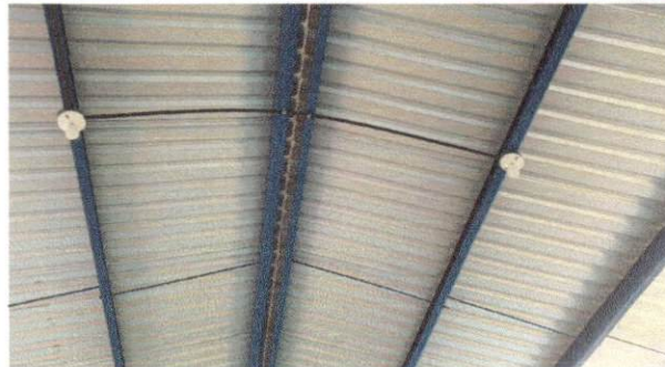
Foto 8: Sustitución de focos ahorradores.
