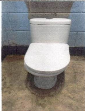
Foto 7: Instalación de inodoro.
