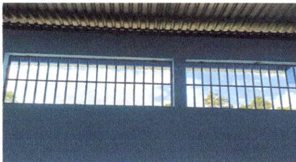
Foto 5: sustitución de balcón de Metal
