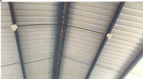
Foto 9: Sustitución de Plafoneras.
