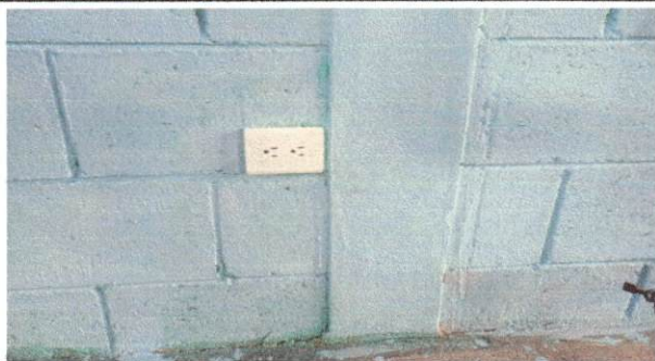
Foto 11: Sustitución de Tomacorrientes Dobles.
