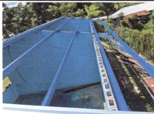
Foto 2: Mantenimiento a estructura de soporte de metal.
