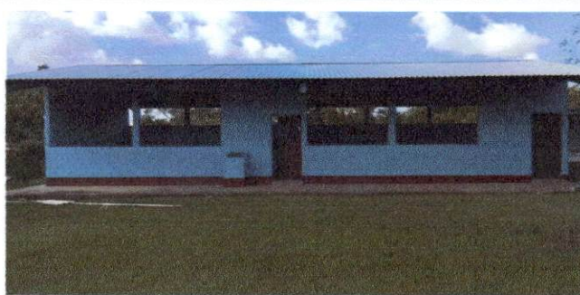
Foto 6: Pintura de muros exteriores e interiores.
