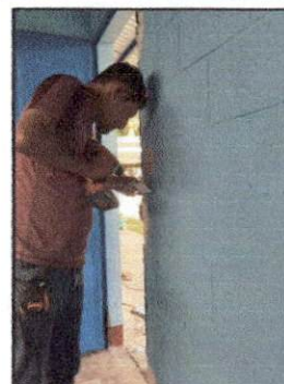
Foto 10: Sustitución de interruptores dobles.
