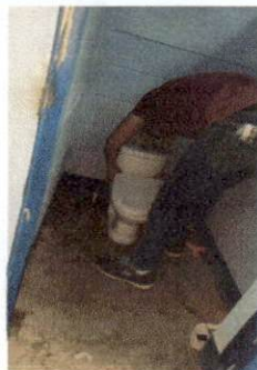
Foto 7: Instalación de inodoro.
