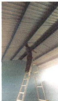
Foto 13: Sustitucion de ducto electrico+accesorios
