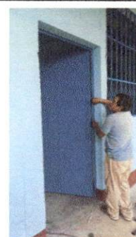
Foto 4: Instalación de puerta.
