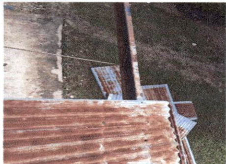
Foto 1: Sustitución de lámina, por lámina troquedala alizinc calibre 26
