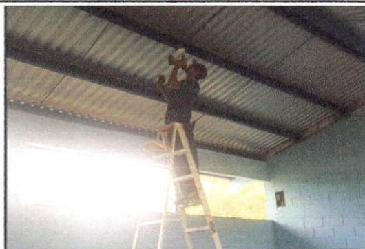
Foto 9: Sustitución de Plafoneras.
