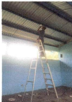
Foto 8: Sustitución de focos ahorradores.
