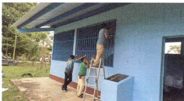
Foto 5: sustitución de balcón de Metal
