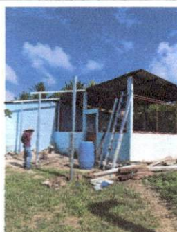
Foto 3: Sustitucion de estructura de soporte de madera por metal
