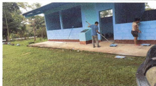
Foto 6: Pintura de muros exteriores e interiores.
