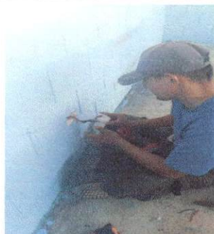
Foto 11: Sustitución de Tomacorrientes Dobles.
