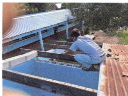
Foto 2: Mantenimiento a estructura de soporte de metal.
