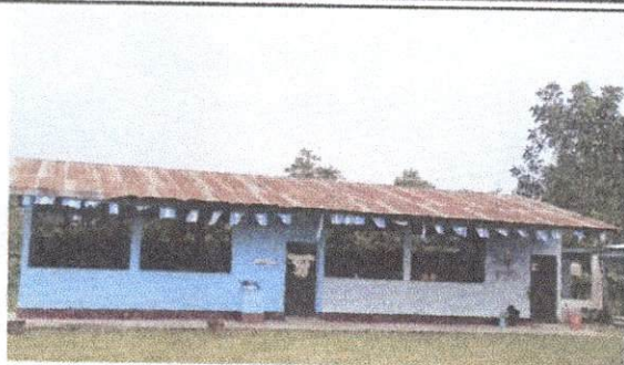
Foto 1: Sustitución de lámina, por lámina troquedala alizinc calibre 26
