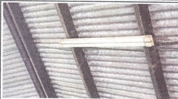
Foto 8: Sustitución de focos ahorradores.
