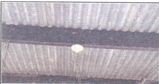
Foto 9: Sustitución de Plafoneras.
