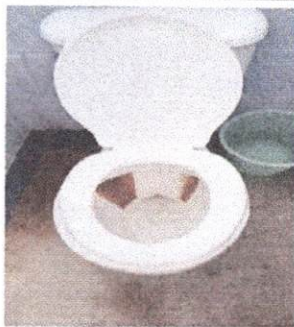
Foto 7: Instalación de inodoro.
