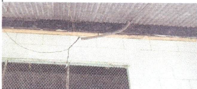
Foto 13: Sustitucion de ducto electrico+accesorios
