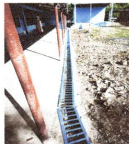
Foto 8: Reparación de cuneta de concreto con rejilla de metal
