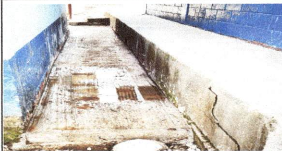
Foto 6: Sustitución de piso de torta de concreto
