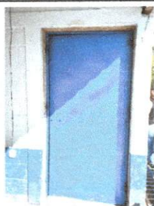
Foto 1: Sustitución de lámina, por lámina troquelada aluzinc calibre 26
