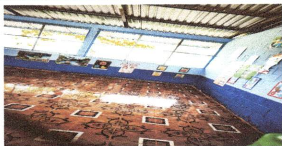
Foto 5: Mejoramiento de piso liso de liso por piso por cerámico
