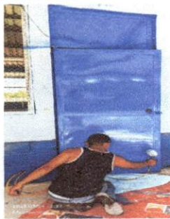
Foto 3: Sustitución de puerta
