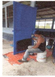
Foto: Mantenimiento a estructura (lijado, cambio de tubo, cepillado, sujeciones, aplicación de pintura)
