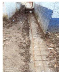
Foto 6: Sustitución de piso de torta de concreto
