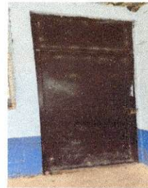
Foto: Mantenimiento a estructura (lijado, cambio de tubo, cepillado, sujeciones, aplicación de pintura)
