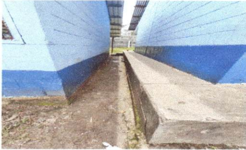
Foto 7: Sustrucción de reposadera de agua
