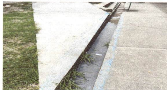
Foto 8: Reparación de cuneta de concreto con rejilla de metal
