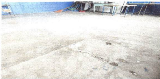
Foto 5: Mejoramiento de piso liso de liso por piso por cerámico
