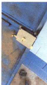
Foto 1: Sustitucion de chapa
