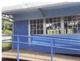
Foto 4: PINTURA EN MUROS EXTERIORES E INTERIORES
