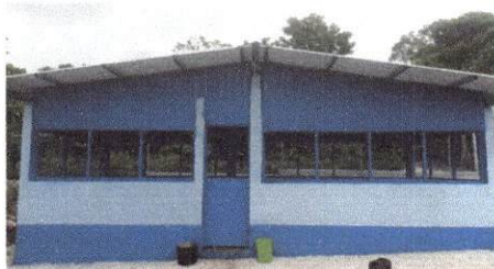
Foto 5: SUSTITUCION DE PUERTA
