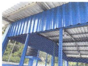
Foto 6: SUSTITUCION DE BALCONES DE METAL
