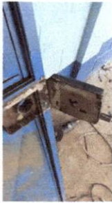
Foto 1: SUSTITUCION DE CHAPA
