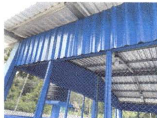
Foto 6: SUSTITUCION DE BALCONES DE METAL
