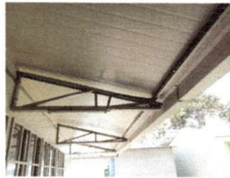
Foto 4: REPARACION DE SISTEMA ELECTRICO
