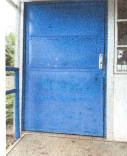
Foto 2: mantenimiento de estructura
