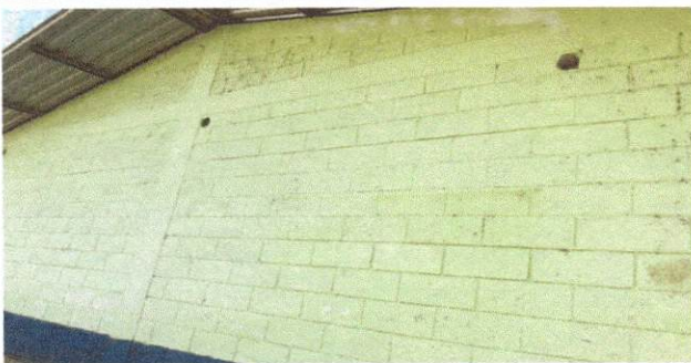
Foto 3: INTURA DE MUROS EXTERIORES E INTERIORES
