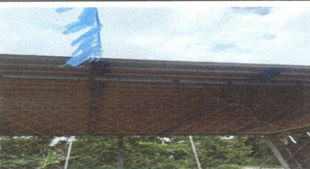
Foto 5: SUSTITUCION DE TECHO DE COCINA
