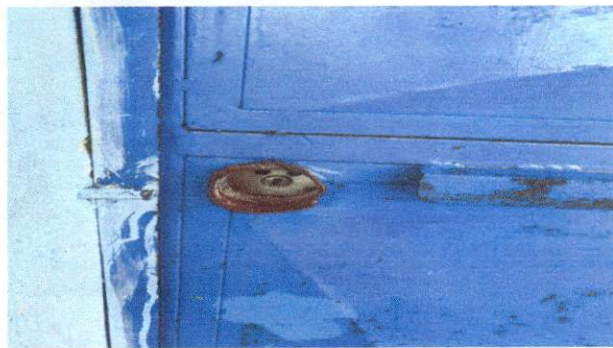
Foto 1: SUSTITUCION DE CHAPA
