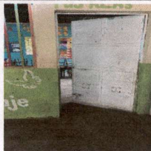
REPARACIÓN DE PUERTA DE METAL
