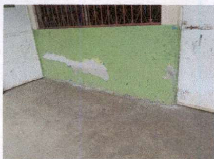
PINTURA EN MUROS EXTERIORES E INTERIORES
