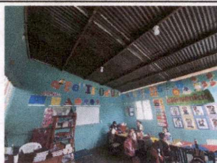
SUSTITUCION DE ESTRUCTURA METALICA
