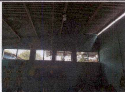
SUSTITUCIÓN DE LAMINA POR LAMINA TROQUELADA ALUZINC.26"
