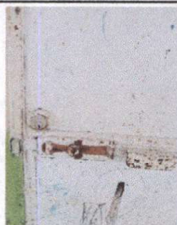
SUSTITUCIÓN DE CHAPA
