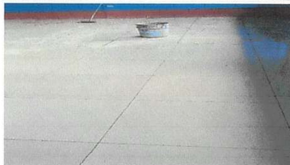
Foto 4: Sustitución de piso cerámico
