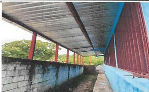
Foto 2: Instalación de lámina troquelada de aluzinc calibre 26
