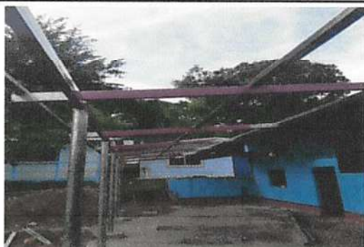
Foto1: Instalación de estructura portante de metal
