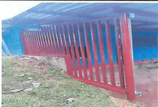
Foto 7: Sustitución de barandas de metal
