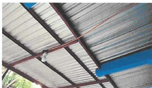
Foto 5: Sustitución de ducto eléctrico mas accesorios
