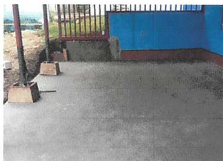
Foto 3: Sustitución de piso de torta de concreto
