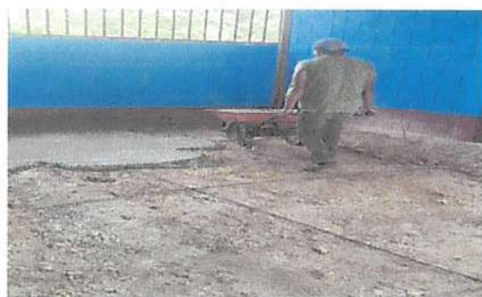
Foto 3: Sustitución de piso de torta de concreto
