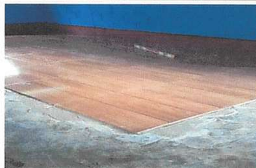
Foto 4: Sustitución de piso cerámico
