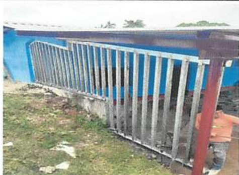
Foto 7: Sustitución de barandas de metal
