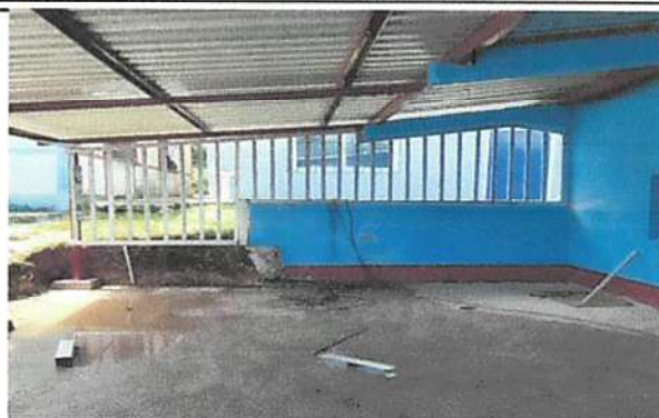
Foto 2: Instalación de lámina troquelada de aluzinc calibre 26
