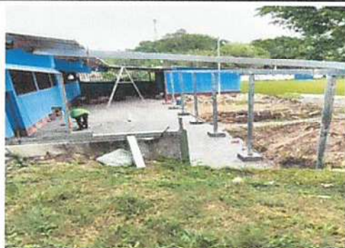
Foto1: Instalación de estructura portante de metal
