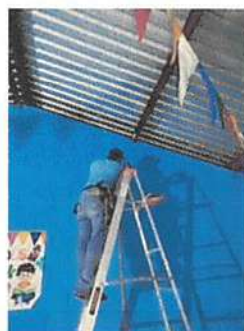
Foto 5: Sustitución de ducto eléctrico mas accesorios
