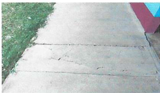
Foto 3: Sustrucción de piso de torta de concreto
