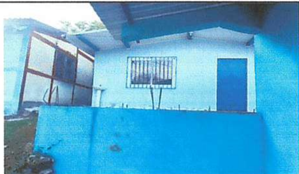
Foto 5: Sustrucción de barandas de metal
