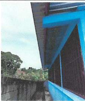
Foto1: Sustrucción de lámina, por lámina troquelada de aluzinc calibre 26
