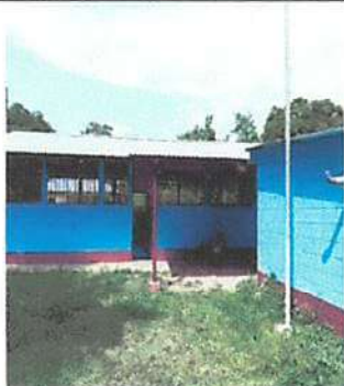
Foto1: Sustrucción de lámina, por lámina troquelada de aluzinc calibre 26
