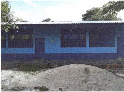
Foto 1: Sustrucción de lamina por lamina troquelada aluzinc calibre 26
