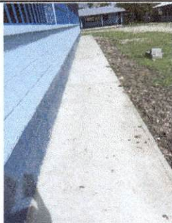
Foto 5: Reparación de banquetas de concreto
