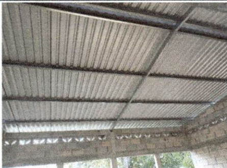
Foto 3: Sustrucción de estructura de madera por metal
