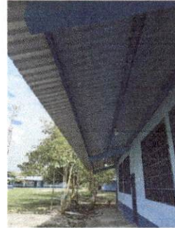
Foto 2: Mantenimiento de estructura de soporte de metal
