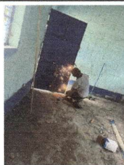
Foto 2: Mantenimiento de estructura de soporte de metal
