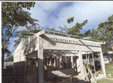
Foto 3: Sustitución de estructura de madera por metal
