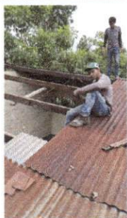
Foto 1: Sustitución de lamina por lamina troquelada aluzinc calibre 26
