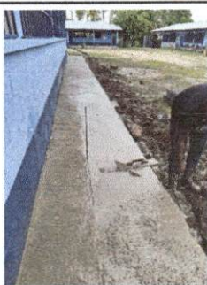
Foto 5: Reparación de banquetas de concreto
