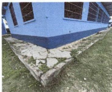
Foto 5: Reparación de banquetas de concreto
