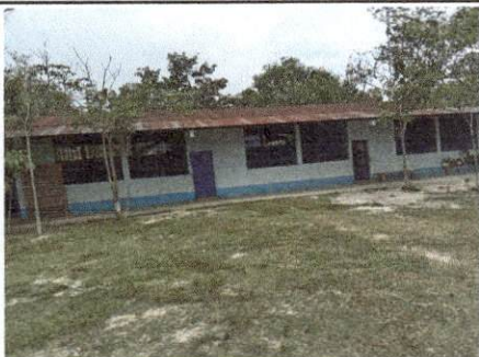
Foto 1: Sustitución de lamina por lamina troquelada aluzinc calibre 26
