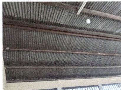
Foto 2: Mantenimiento de estructura de soporte de metal
