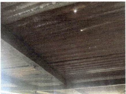
Foto 3: Sustitución de estructura de madera por metal
