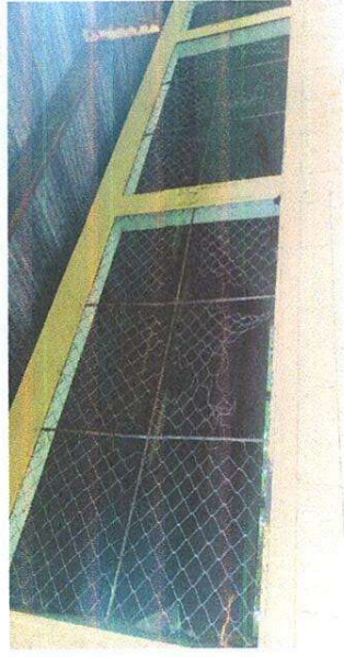
Foto: 6 Sustitución de estructura de soporte de metal
