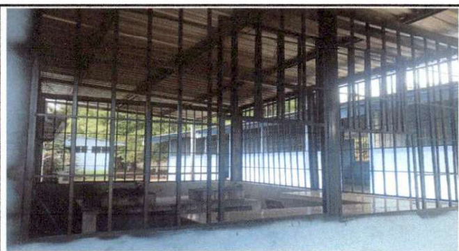
Foto 5: Mantenimiento a balcones de metal
