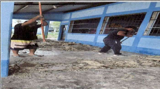
Foto 3: Sustitución de piso de torta de concreto
