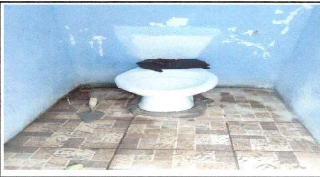
Foto 5: Sustitucion de Sanitarios
