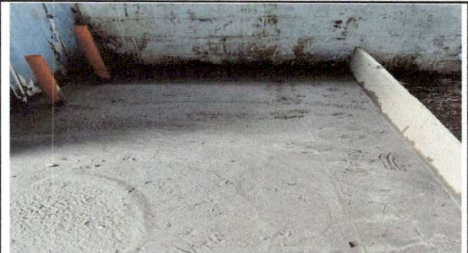
Foto 2: reparacion piso de concreto rustico
