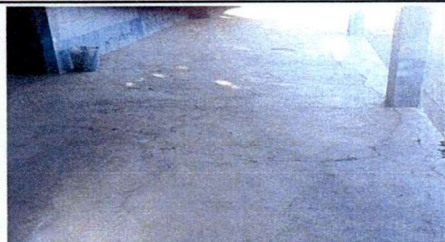
Foto 3: SUSITUCION DE PISO DE CONCRETO DE CORREDOR
