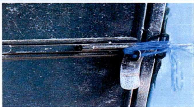
Foto 7: Sustitución de chapa
