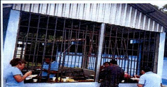
Foto 5: MANTENIMIENTO A BARANDA DE METAL
