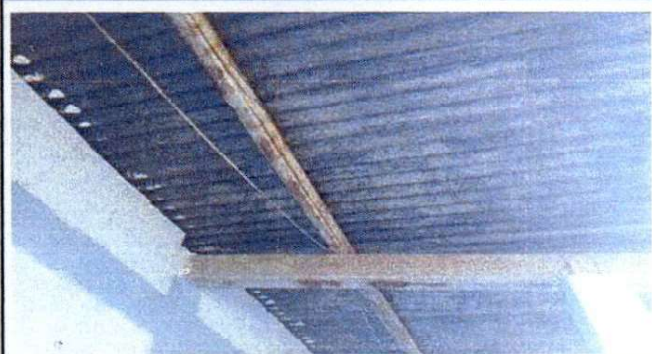
Foto 1: SUSTITUCION DE ESTRUCTURA DE MADERA POR METAL
