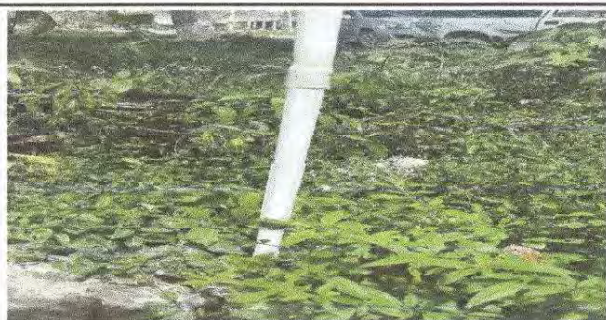
Foto 11: Sustitucion de tuveria de linea principal
