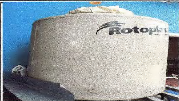
Foto13: Sustitucion de deposito de agua de 1700 litros
