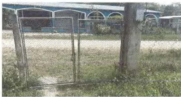
Foto 8: Fabricacion e instalacion de porton de metal de ingreso
