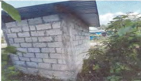
Foto 10: Repello en muro
