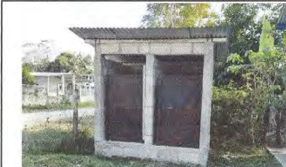
Foto7: Fabricacion e instalacion de puertas de metal en baños
