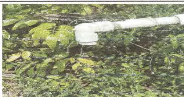
Foto 12: Sustitucion de llaves de chorros
