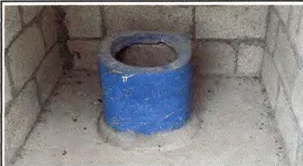
Foto 15: Sustitucion de inodoros
