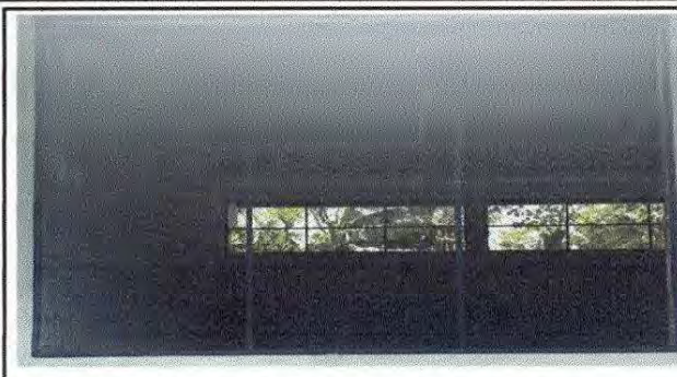
Foto 14: Fabricacion e instalacion de ventanas-balcon de metal
