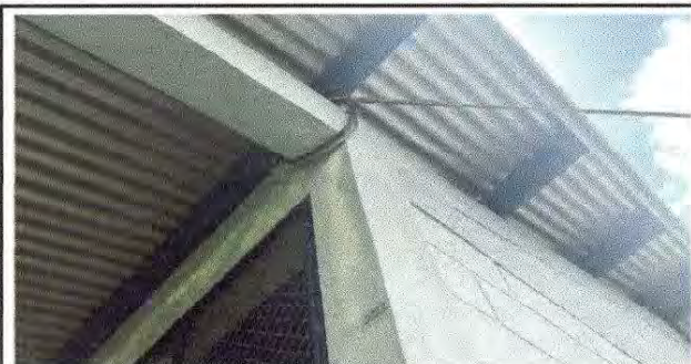
Foto 6: Sustitucion de ducto electrico + accesorios
