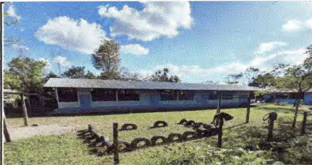
Foto 3: Pintura en muros exteriores e interiores
