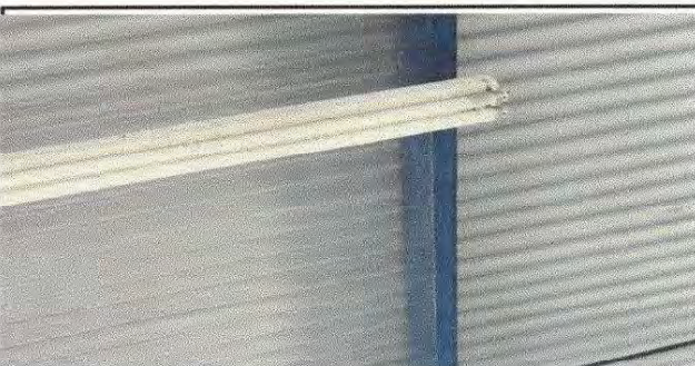
Foto 5: Sustitución de Lamparas tipo Led
