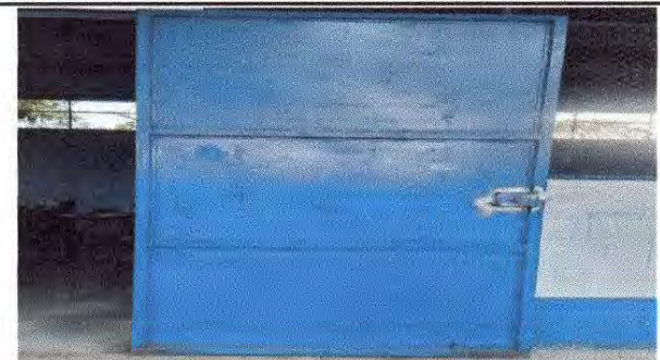
Foto 4: Sustitucion de chapas
