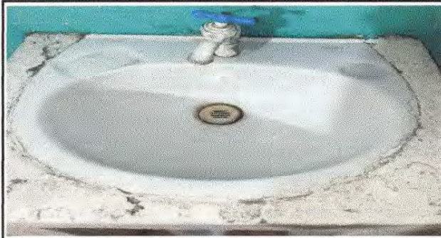
Foto 16: Sustitucion de lavamanos
