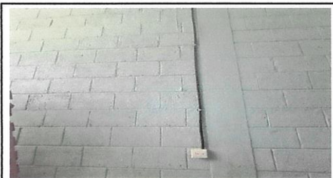
Foto 3: Instalación de unidades de fuerza.
