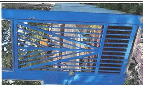
Foto 2: Fabricación en instalación de portón de metal de ingreso.
