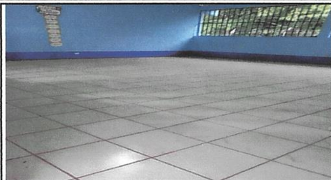
Foto1: Sustitución de piso cerámico.
