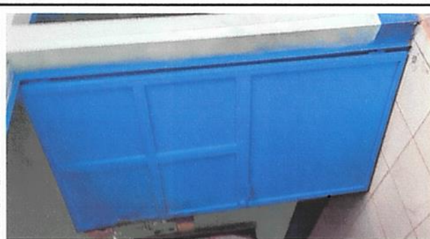
Foto 4: Mantenimiento a estructura de puertas de metal.
