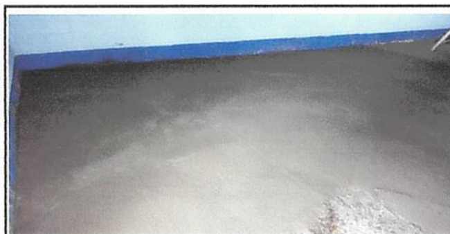
Foto 5: Reparación de piso de torta de concreto.
