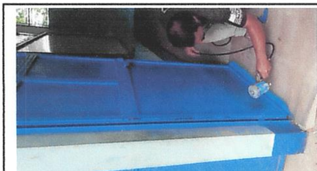
Foto 6: Mantenimiento a estructura de puertas de metal.
