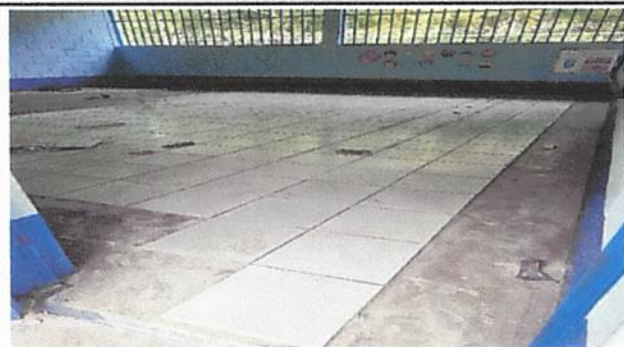
Foto1: Sustrución de piso cerámico.
