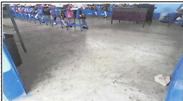
Foto 1: Sustrucción de piso en aula.
