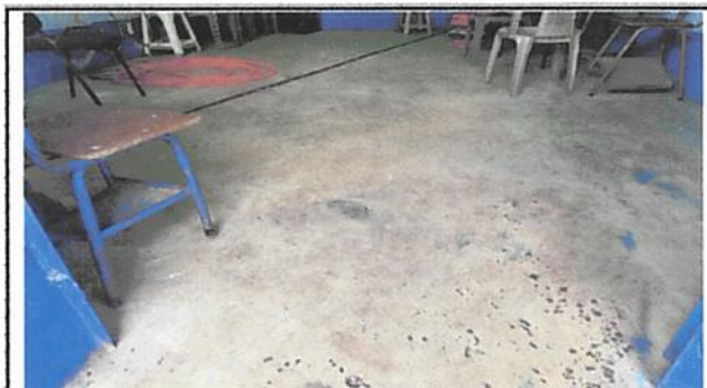
Foto 3: Sustrucción de piso en aula.
