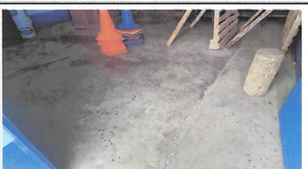
Foto 4: Reparación y nivelación de torta.
