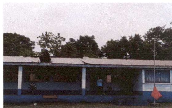
Sustitucion de lamina por lamina
