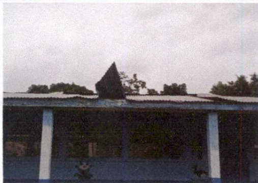
Sustitucion de madera por metal
