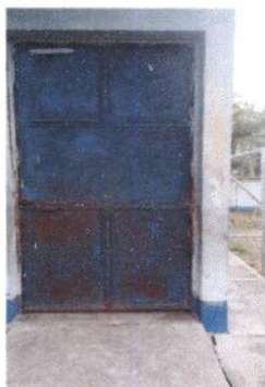
Fabricacion e Instalacion Puertas
