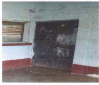
SUSTITUCIÓN DE PUERTA DE METAL POR METAL ✓
