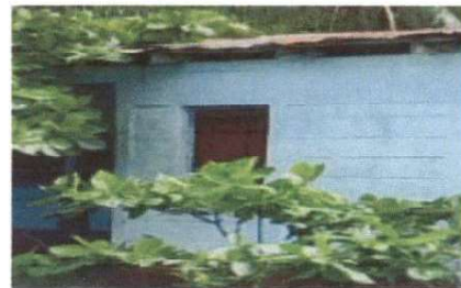
SUSTITUCIÓN DE VENTANA DE MADERA POR METAL ✓
