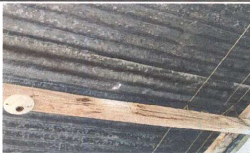
SUSTITUCION DE PLAFONERA ✓
