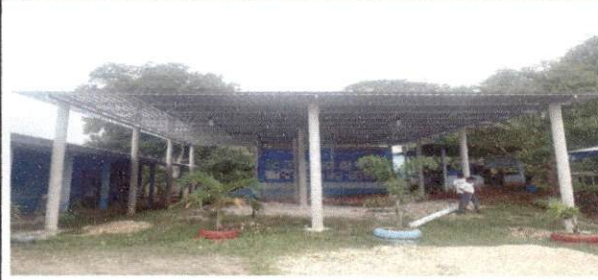
Foto 2: Sustrución de estructura de soporte de metal
