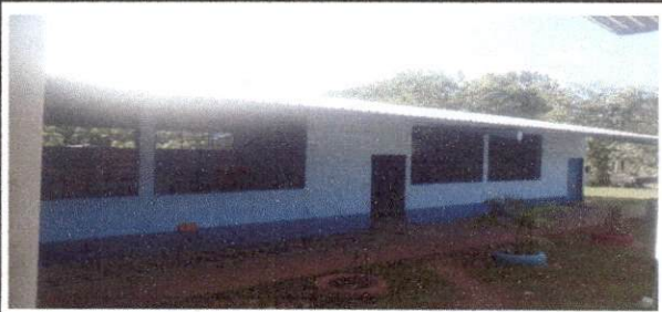
Foto 4: Pintura en muros exteriores e interiores
