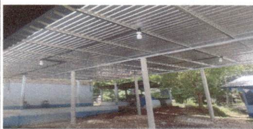
Foto 5: Reparación de cableado electrico
