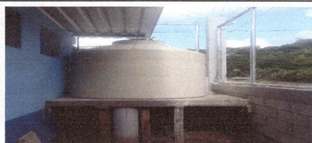
Foto 8: Sustitución de deposito de agua 1700 lt
