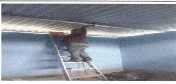
Foto 6: Instalación de unidades luz (incluye interruptor, ducto y cable eléctrico)
