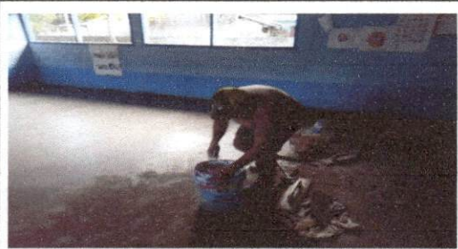
Foto 3: Sustrucción de piso de torta de concreto
