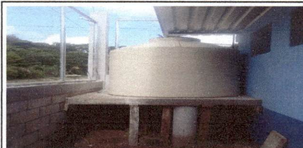
Foto 8: Sustitución de deposito de agua 1700 lt
