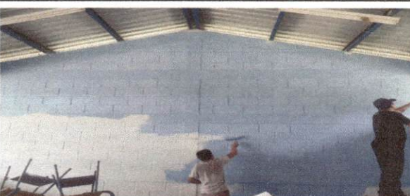
Foto 4: Pintura en muros exteriores e interiores
