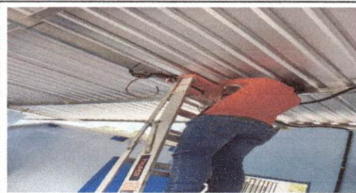
Foto 5: Reparación de cableado eléctrico
