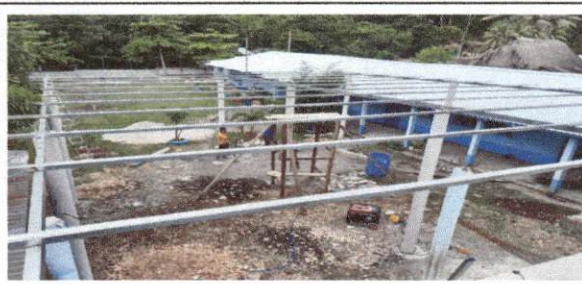
Foto 2: Sustrucción de estructura de soporte de metal
