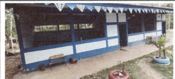
Foto 4: Pintura en muros exteriores e interiores
