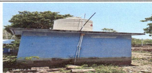
Foto 8: Sustitución de depósito de agua 1700 lt
