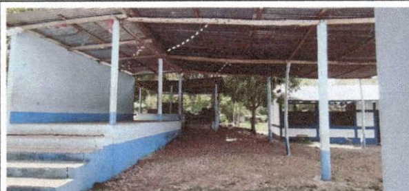
Foto 2: Sustrucción de estructura de soporte de metal
