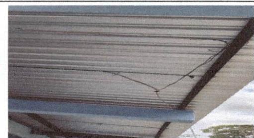
Foto 5: Reparación de cableado eléctrico
