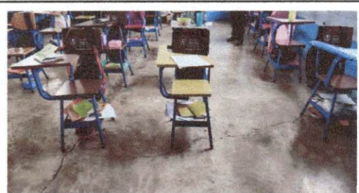
Foto 3: Sustrucción de piso de torta de concreto
