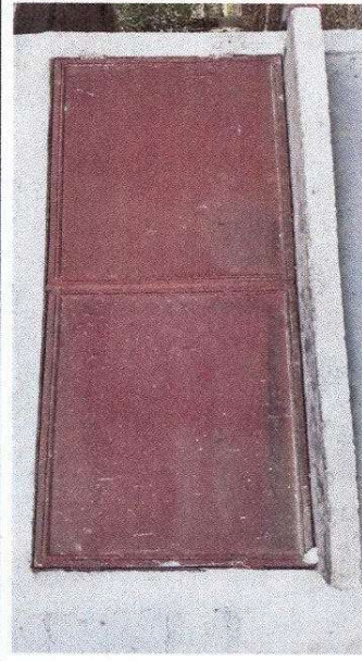
Foto 3: Mantenimiento a balcones de metal
