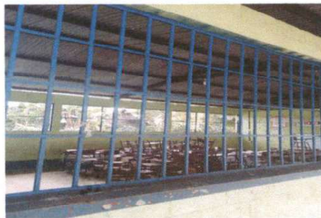
MANTENIMIENTO DE BALCONES DE METAL (5.1)
