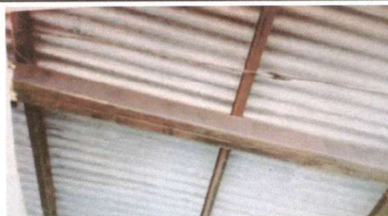
MANTENIMIENTO DE ESTRUCTURA DE SOPORTE DE METAL(2.1)
