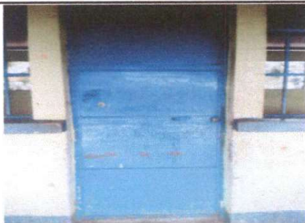
MANTENIMIENTO A ESTRUCTURA(ALIJADO, CEPILLADO, APLICACIÓN DE PINTURA) (4.1)
