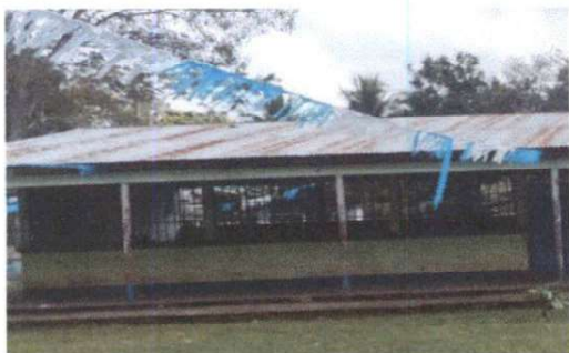
SUSTITUCIÓN DE LAMINA POR LAMINA TROQUELADA ALUZINC.26"(1.1)
