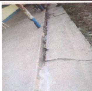
SUSTITUCION DE PISO DE TORTA DE CONCRETO (6.5)
