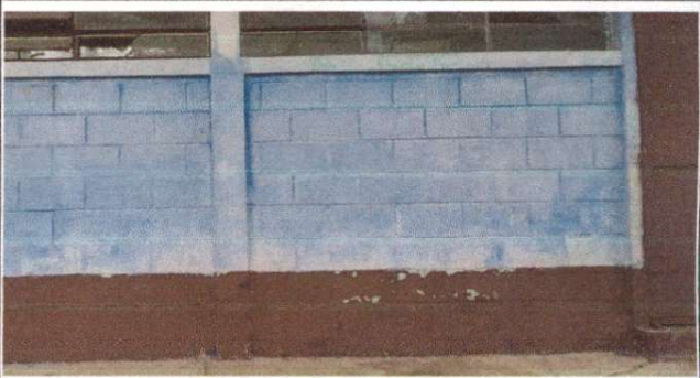
PINTURA EN MURO INTERIOR Y EXTERIOR DE AULAS
