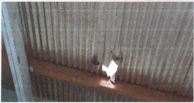
SUSTITUCION DE LAMINA POR LAMINA GALVANIZADA ALUZINC
