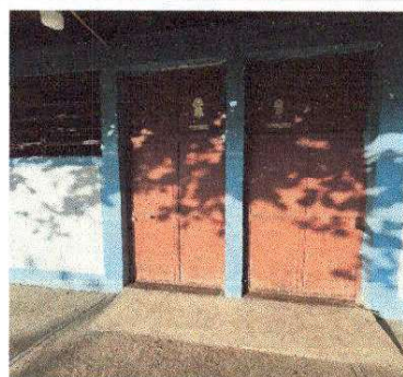
SUSTITUCIÓN E INSTALACIÓN DE PUERTAS DE METAL EN BAÑOS
