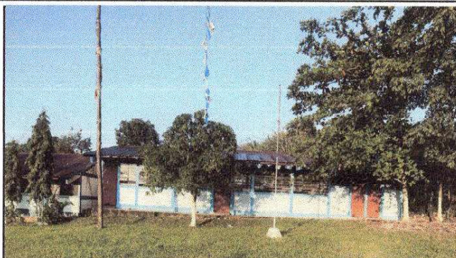
SUSTITUCION DE LAMINA GALVANIZADA
