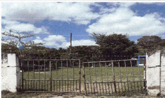
FABRICACIÓN E INSTALACIÓN DE PORTÓN PRINCIPAL
