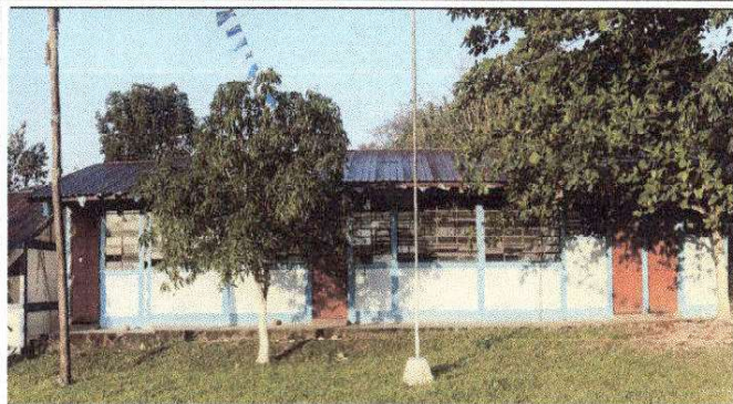
REPARACION Y MANTENIMIENTO DE ESTRUCTURA DE TECHO
