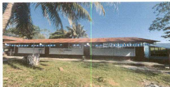
Foto 4: Pintura en muros exteriores e interiores
