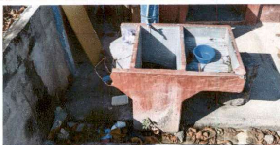
Foto 9: Sustrución de pila de cemento de dos lavadero
