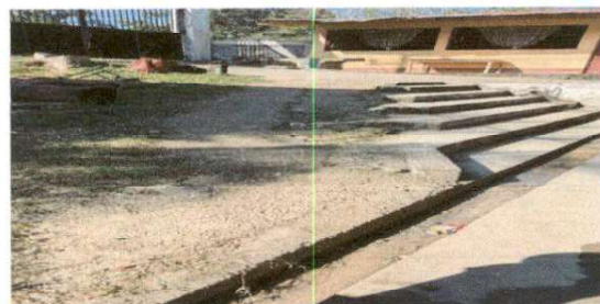
Foto 6: Sustitución de piso de torta de concreto
