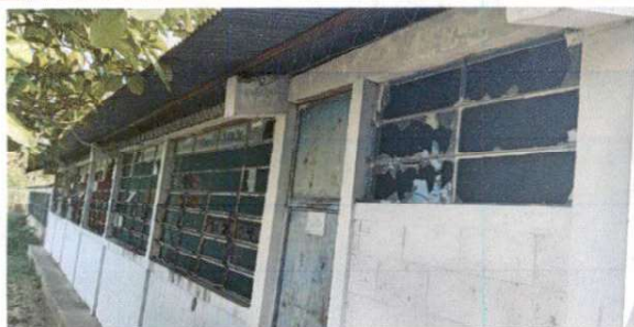
Foto 7: Sustrución de balcones de metal
