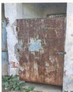
Foto 3: Sustitución de puerta en servicios sanitarios
