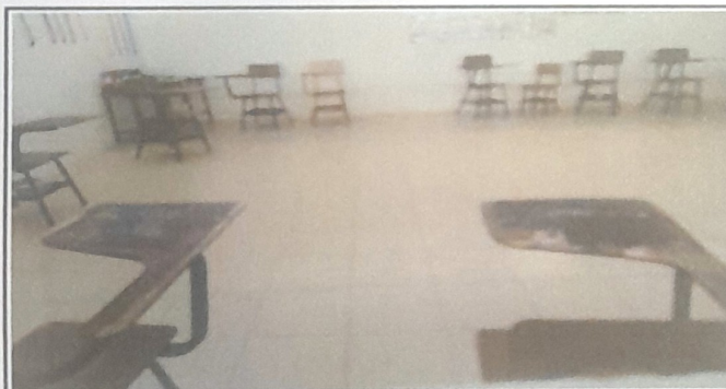
Foto 5: 6.8 Sustitución de piso cerámico
