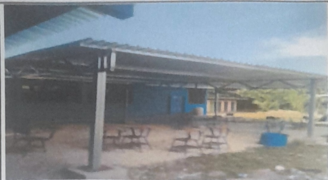
Foto 1: Sustitución de lámina por lámina troquelada aluzinc, calibre 26. 1.2: Sustitución de capote de lámina para lámina troquelada. 1.3: Sustitución de elementos de fijaciones. 2.1 Mantenimiento a estructura.
