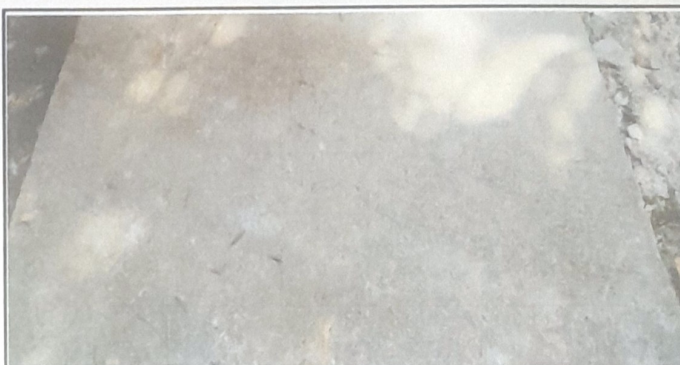
Foto 4: 22.1 Reparación de muro de contención
