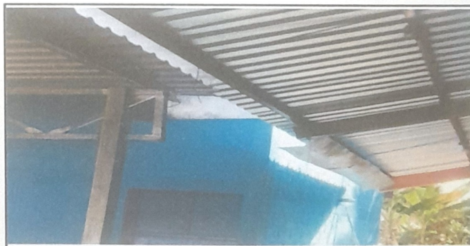
Foto 6: 7.1 Sustitución de canal de metal
