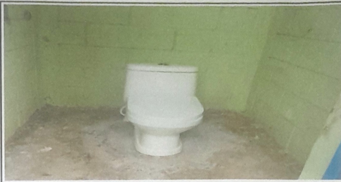
Foto 2: 10.4 Sustitución de inodoro
