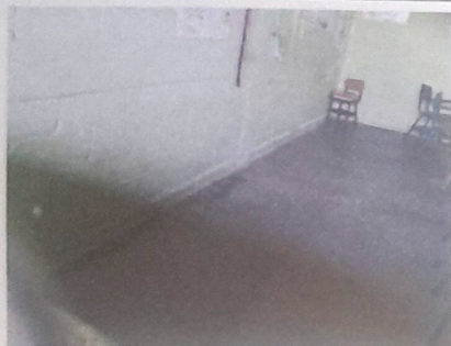
Foto 3: Reparación de piso de torta de concreto
