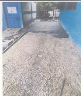
Foto 4: Reparación de banquetas de concreto
