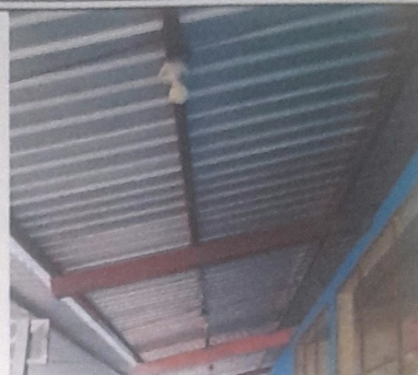
Foto 2: Mantenimiento a estructura de soporte de metal
