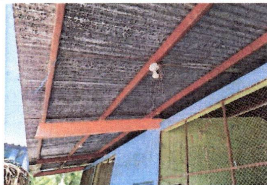
Foto 2: Mantenimiento a estructura de soporte de metal
