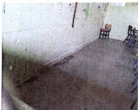
Foto 3: Reparación de piso de torta de concreto
