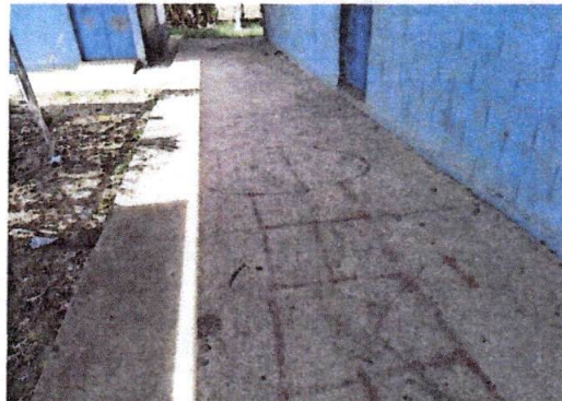
Foto 4: Reparación de banquetas de concreto
