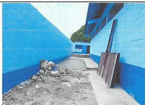
Foto 5: reparación de muro de contención dentro y fuera repello y pintura
