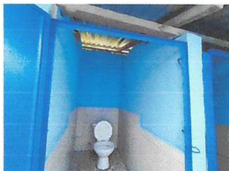
Foto 2: aplicación de pintura dentro y fuera de baños, paredes y puertas.
