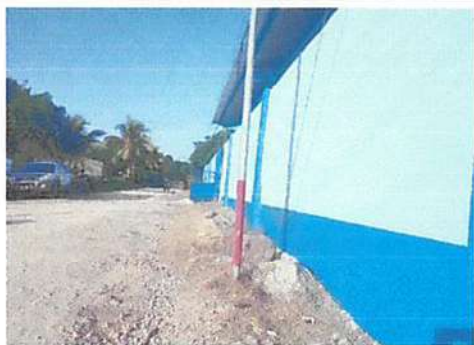
Foto 1: Reparación, repello, sernido y aplicación de pintura en muro perimetral
