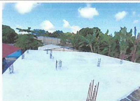
Foto 6: finalización de impermeabilización de terraza
