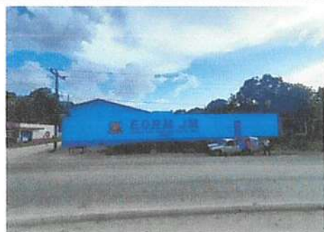
Foto 3: aplicación de repello y pintura de muro perimetral
