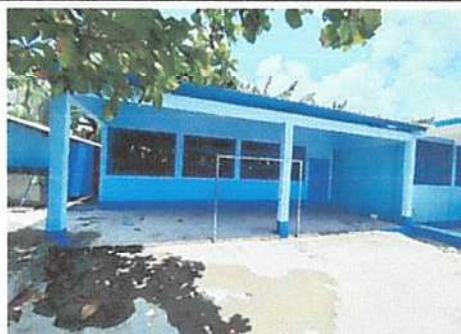
Foto 4: aplicación de pintura dentro y fuera de las aulas
