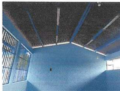
Foto 2: aplicación de pintura dentro y fuera de aulas, paredes, costaneras y puertas.
