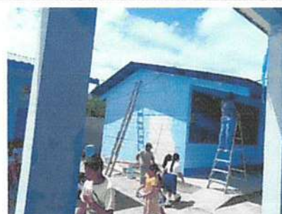
Foto 4: aplicación de pintura dentro y fuera de las aulas
