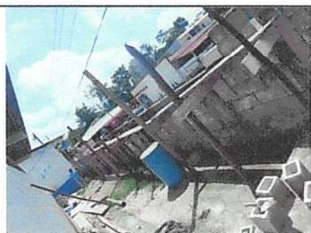
Foto 3: aplicación de repello de muro perimetral
