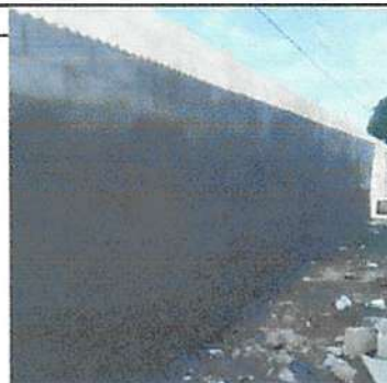
Foto 6: aplicación de repello en muro perimetral
