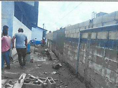
Foto 1: Reparación, repello, sernido en muro perimetral
