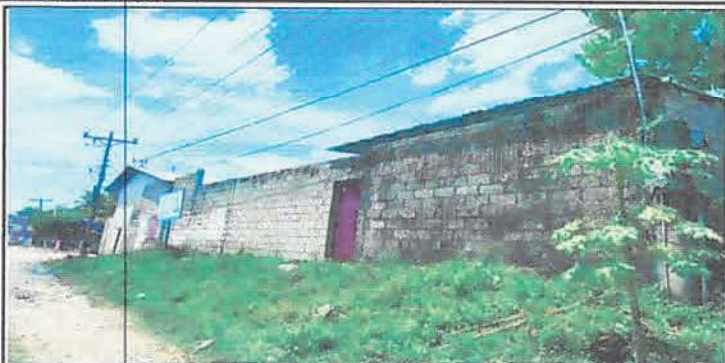
Foto 1: REPARACIÓN DE MURO DE CONTENCIÓN: APLICACIÓN DE REPELLO
