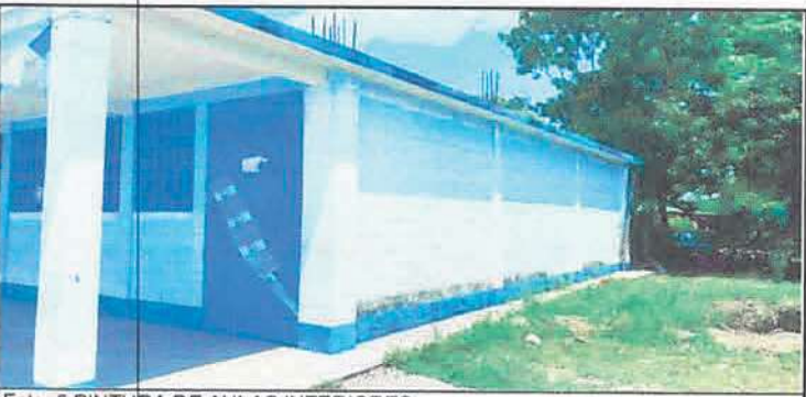
Foto 5: PINTURA DE AULAS INTERIORES
