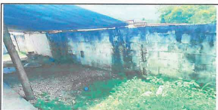
Foto 4: REPARACIÓN DE MURO DE CONTENCIÓN
