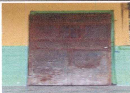
4.3 Sustitución de puerta
