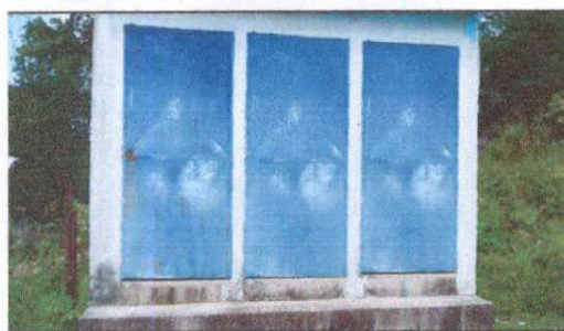
4.4 Sustitución de puertas en servicios sanitarios
