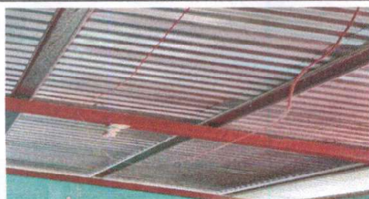
19.14 Instalación de acometida eléctrica
