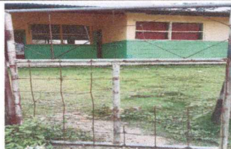
4.5 Sustitución de portón de metal
