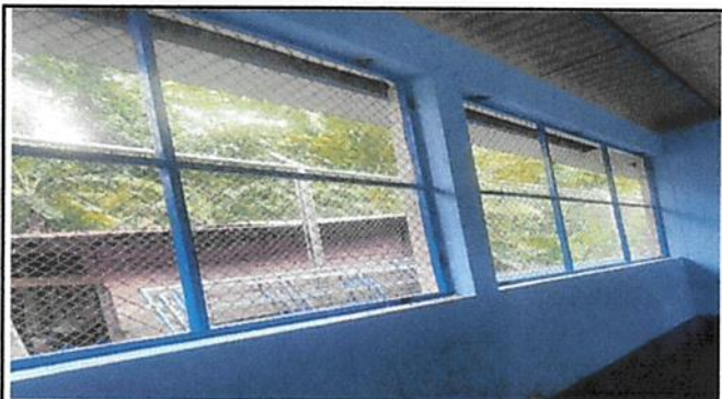
Foto 3: Sustitución de balcones de metal
