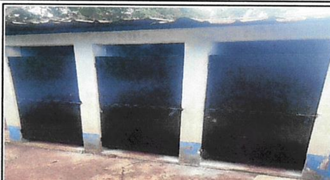
Foto 2: Sustitución de puerta
