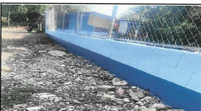
Foto 4: Pintura en muros exteriores e interiores
