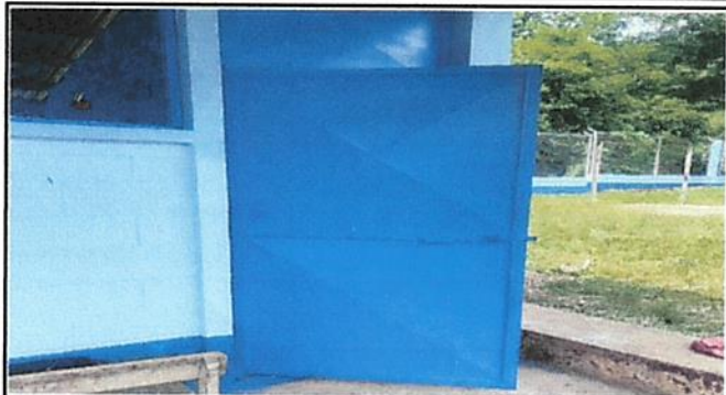
Foto 1: Mantenimiento a puerta de metal.
