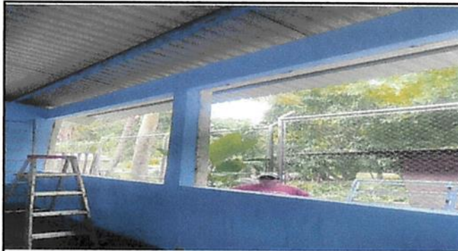
Foto 3: Sustitución de balcones de metal
