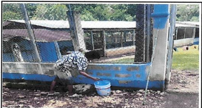
Foto 4: Pintura en muros exteriores e interiores
