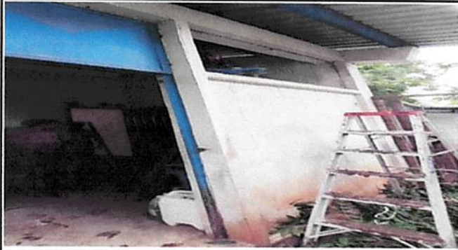
Foto 1: Mantenimiento a puerta de metal.
