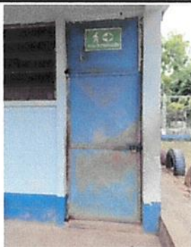
Foto 1: Mantenimiento a puerta de metal.
