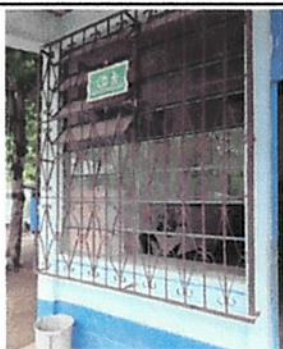
Foto 3: Sustitución de balcones de metal
