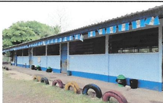
Foto 4: Pintura en muros exteriores e interiores
