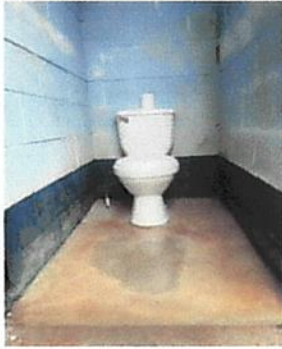
Foto 7: Sustitución de piso cerámico en 03 baños.
