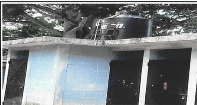
Foto 5: Sustitución de deposito de agua 1700 lt
