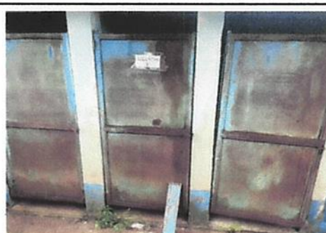
Foto 6: Sustitución de puertas
