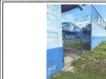
Sustitución de portón de metal
