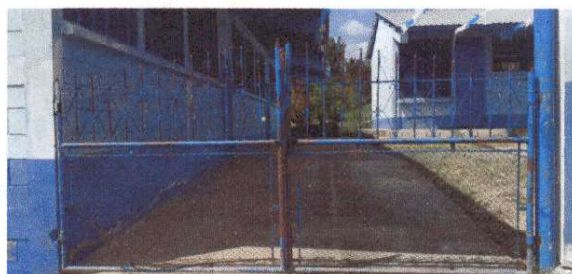
Sustitución de portón de metal
