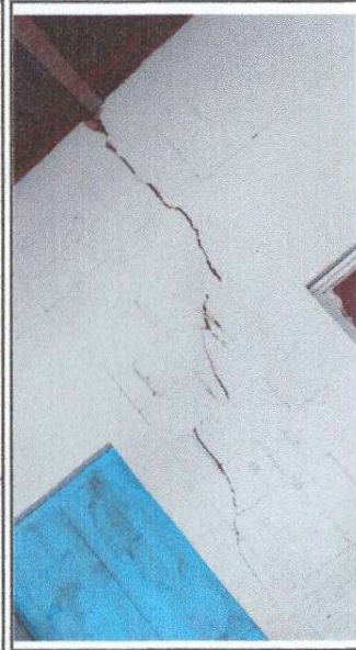
REPARACION DE MURO DE AULA
